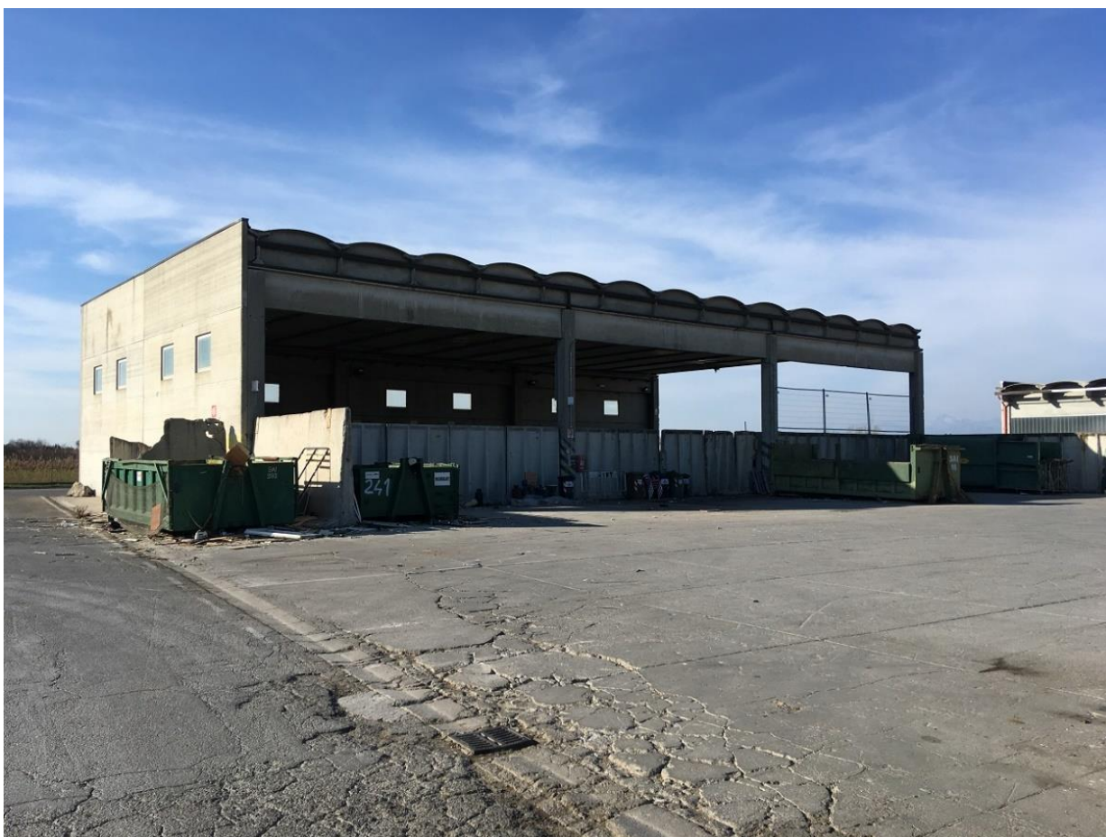
Capannone ad uso tettoia da convertire in officina – Sede di Pisa Via Granuccio
