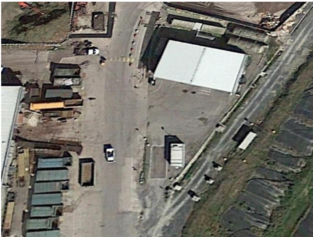
Impianto di lavaggio coperto – Sede di Pontedera - Viale America
