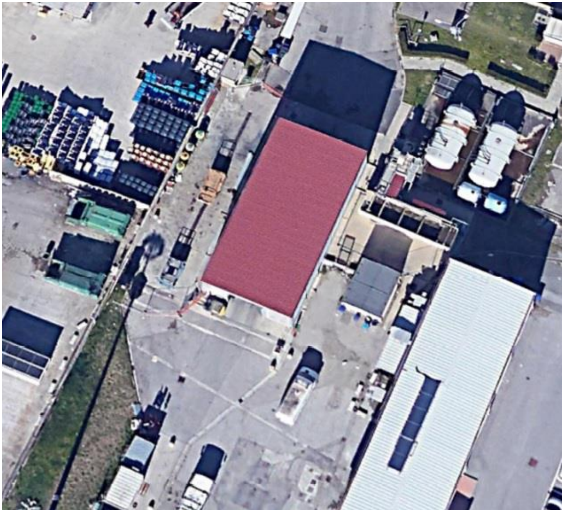
Impianto di lavaggio coperto – Sede di Pisa - Via Granuccio
